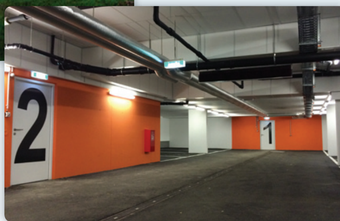
Helle großzügige Tiefgarage mit direktem Liftzugang
